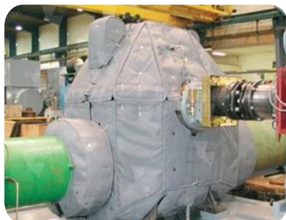
Размер: под оборудование Площадь изоляции: 1,000 м 2
